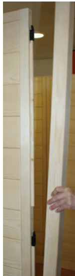
Abb. 10: Montage der beiden vorderen Eckelemente mit Nut für Glasführung
