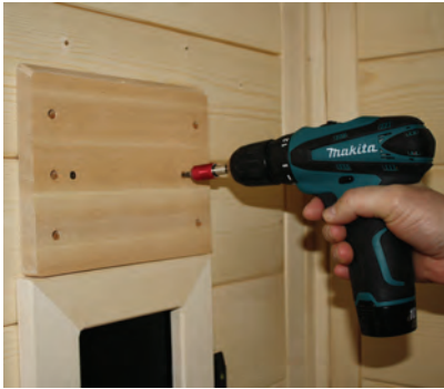
Abb. 44: Montage der Kofstützen
