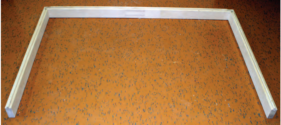
Abb. 1: Auflegen der drei Bodenrahmen-Elemente
