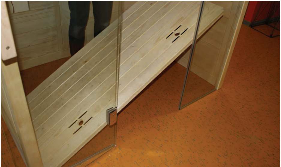
Abb. 27: Kabinenboden einlegen
