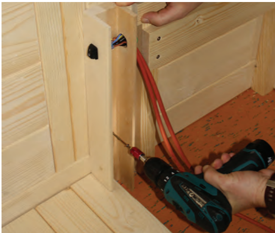
Abb. 32: Montage der Wadenstrahler-Aufnahme
