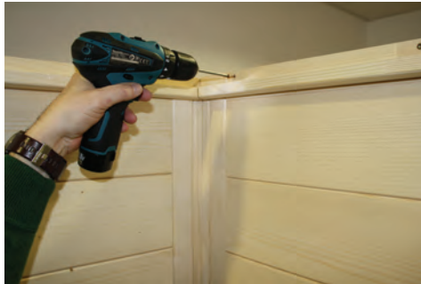
Abb. 16: Montage der Dachauflageleisten
