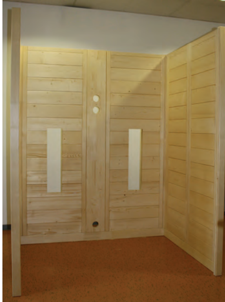
Abb. 11: Montierte Wandelemente
