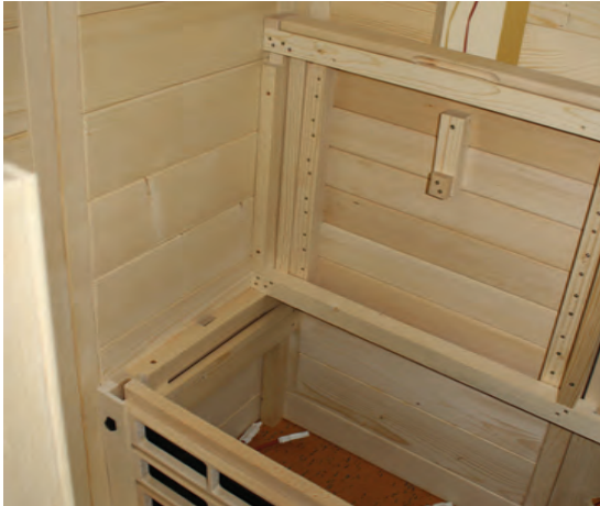
Abb. 52: Montage der Bank 1
