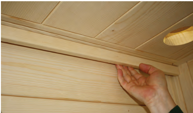
Abb. 38: Einkleben des LED Stripes
