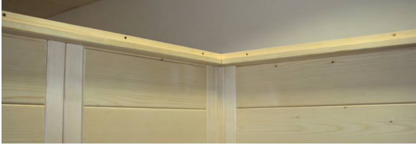
Abb. 17: Montage der Dachauflageleisten
