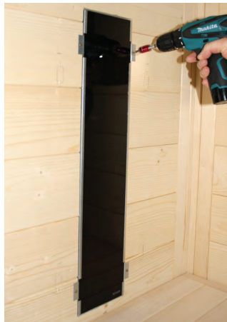
Abb. 41: Rückenstrahler montieren 2
