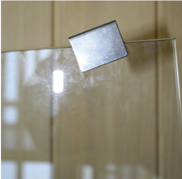
Abb. 24: Montage Türschließer-Blech
