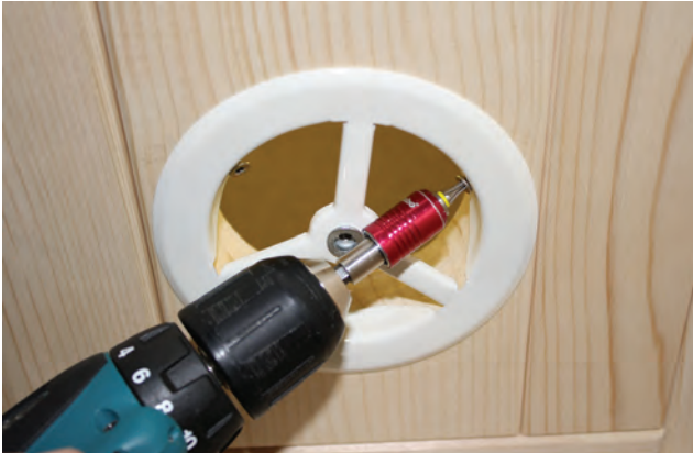
Abb. 35: Montage der Entlüftung
