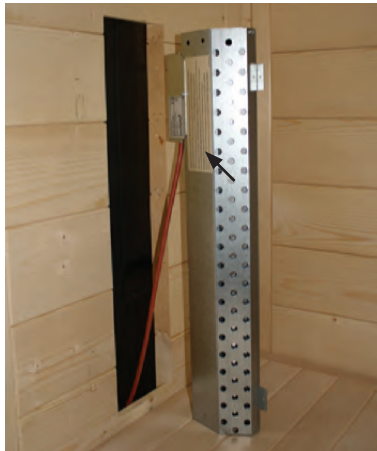
Abb. 40: Rückenstrahler montieren 1
