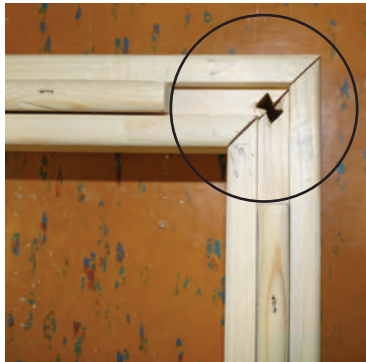
Abb. 2: Auf korrekte Flucht der Nut achten
