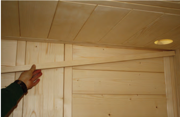
Abb. 37: Montage der Lichtleiste
