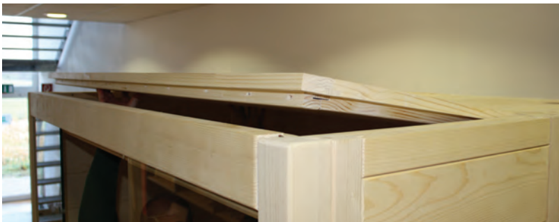
Abb. 19: Einlegen der Dachelemente 2
