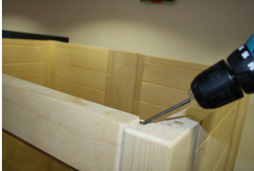
Abb. 15: Befestigen der Dachleiste
