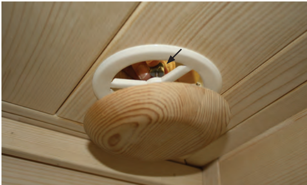
Abb. 36: Einkleben des LED Stripes
