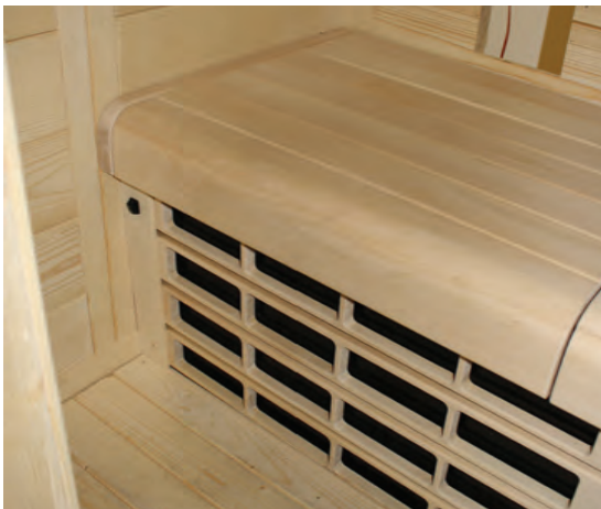
Abb. 53: Montage der Bank 2
